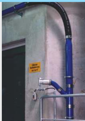
Стационарный вакуумпровод с постом для подключения
